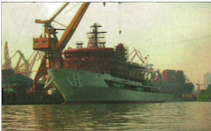
Строительство судна спасения ПЛ на судовой верфи Гуанчжоуской международной судостроительной компании
